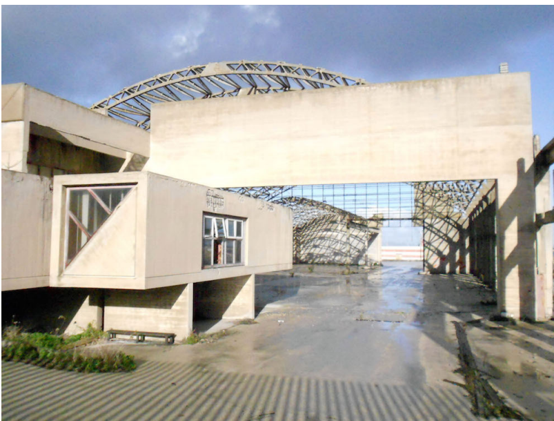
Fig. 3. Un ex stabilimento produttivo interamente realizzato in calcestruzzo armato, richiede la valutazione della sua consistenza materica e del flusso di rifiuti indotto dagli interventi di riqualificazione (foto di A. Monsù Scolaro)
